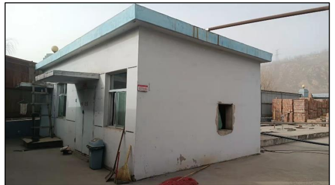
华焯选煤厂生活污水处理站（依托）
