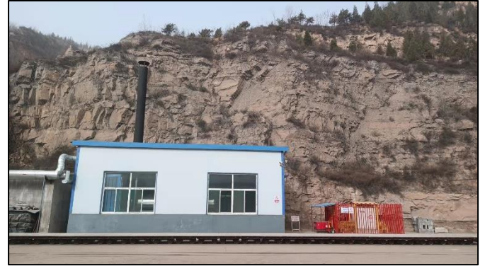
6 t/h 燃气锅炉房
